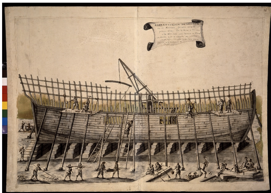
LÁMINA 1 Diccionario demostrativo con la configuración y anatomía de toda la arquitectura naval moderna - Construcción de una Fragata
